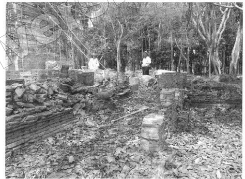
2. ระเบียงคด ถ่ายจากทิศตะวันออกเฉียงใต้ เมื่องานบูรณะยังไม่แล้วเสร็จ
