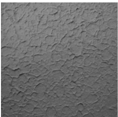
ภาพที่ 48 การฉีบน้ำแรง
