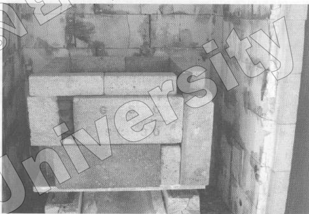
ภาพที่ 8 ใช้ดินอุดบริเวณที่มีรูหรือบริเวณที่ปิดไม่สนิท
