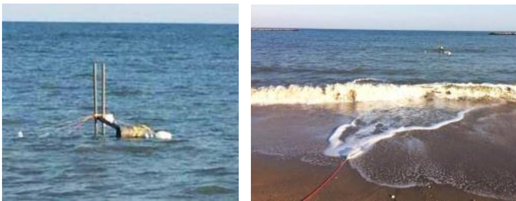
ภาพที่ 5 การติดตั้งและทดสอบอุปกรณ์วัดศักยภาพพลังงานคลื่นทะเล
