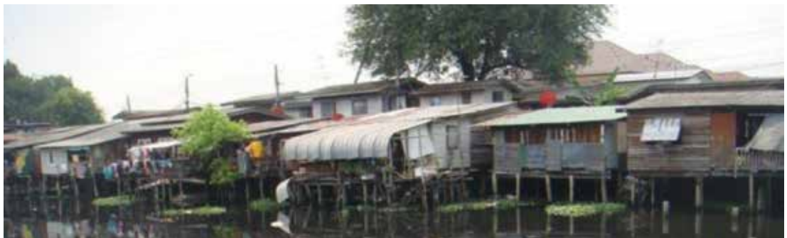
ภาพที่ 5 สภาพบ้านพักอาศัยที่บุกรุกในคลอง และเป็นต้นเหตุของการทิ้งขยะมูลฝอยลงในแหล่งน้ำ
