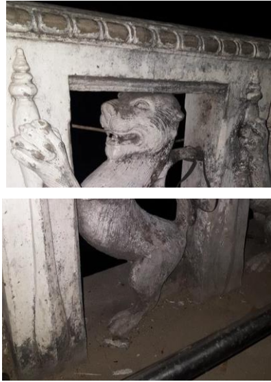
ภาพที่ 4 คราบสกปรกดำบดบังความสวยงามของสะพาน
