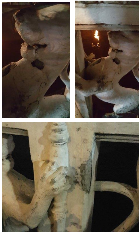
ภาพที่ 5 ลวดลายแตกหักเสียหายของสะพาน
